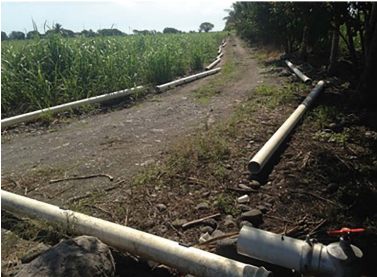
Figura 1. Sistema de riego de baja presión entubado con multicompuertas.
