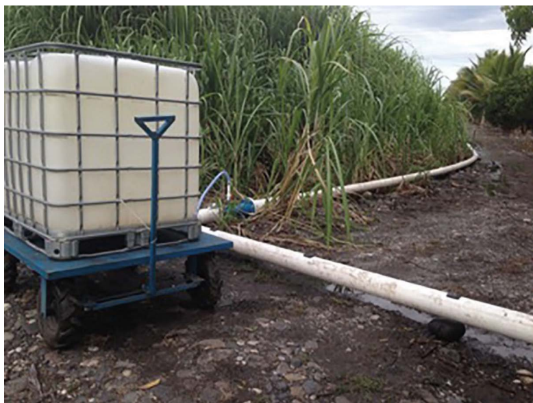
Figura 4. Pruebas del sistema de fertirrigación en campo.
