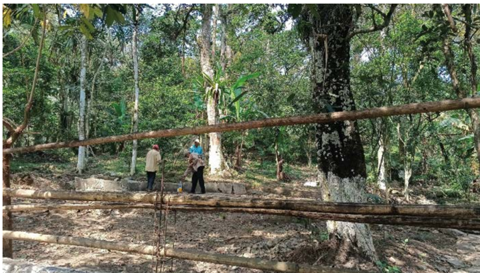
Figura 1. Predio donde se construye el Parque Agroambiental Tequecholapa en Naranja, Veracruz.
