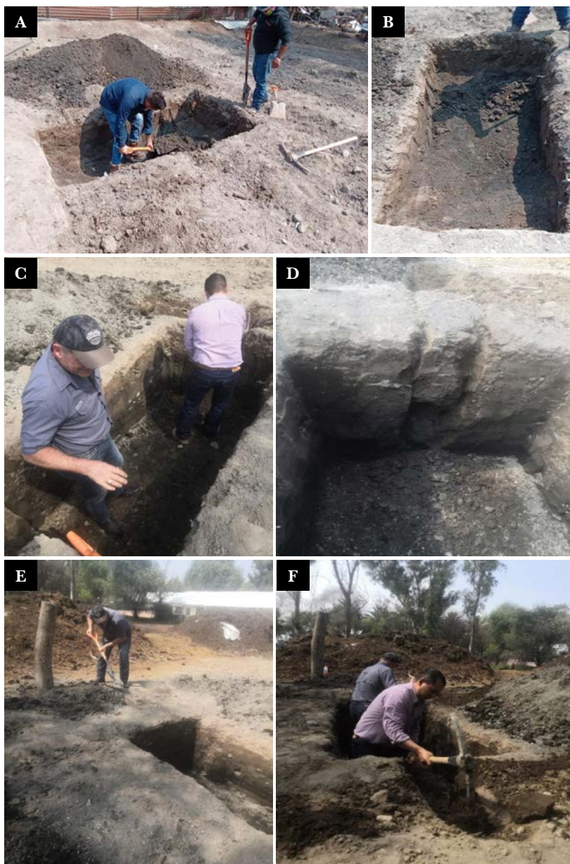
Figura 2. Dimensiones de la fosa realizada en el área de Traspatio del Colegio de Postgraduados. A) Dimensionando el área; B) medidas que se lleva una carbonera 1.5 m de ancho, 1 m de profundidad y 3 m de largo; C) acabado de cada pared para que no se genere obstrucciones; D) área de respiradero; E) colocando la tierra a modo que no quede lejos F) realización del área de respiradero (30 cm de ancho) en ángulo de 45°.
