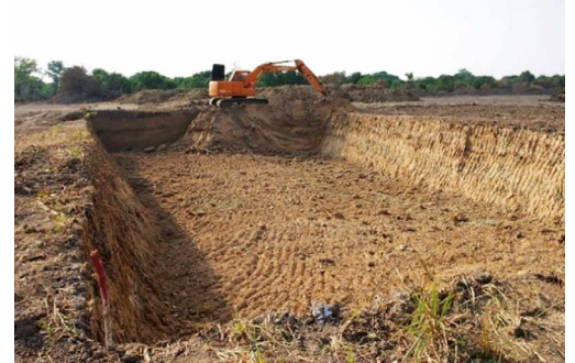
Figura 2. Cuenca de captación de agua de lluvia (arriba) y Excavación para el almacenamiento del agua de lluvia (abajo).
